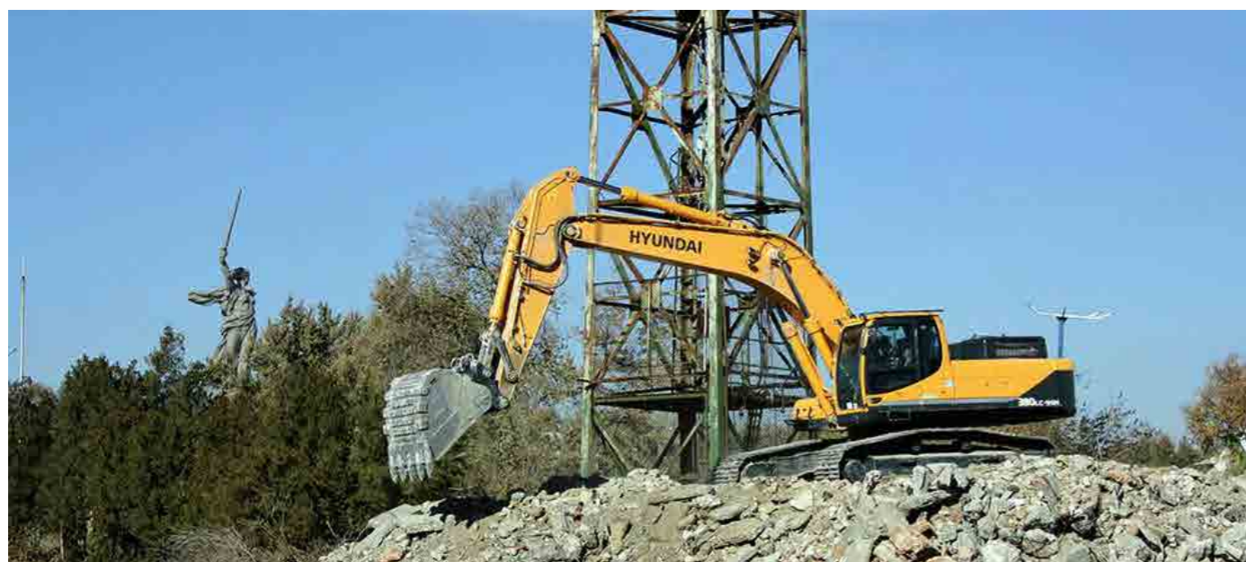
Механизированный демонтаж стадиона г. Волгоград, 2014 год, ГСК «Реформа»
