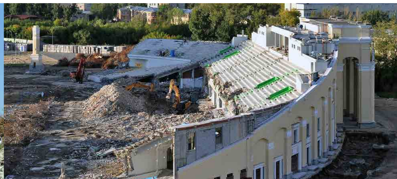
Демонтаж с сохранением исторических стен «Центральный стадион», г. Екатеринбург, 2016 год
