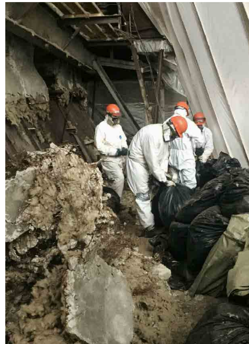
Один из этапов упаковки снятой асбестосодержащей изоляции, ГСК «Реформа»
