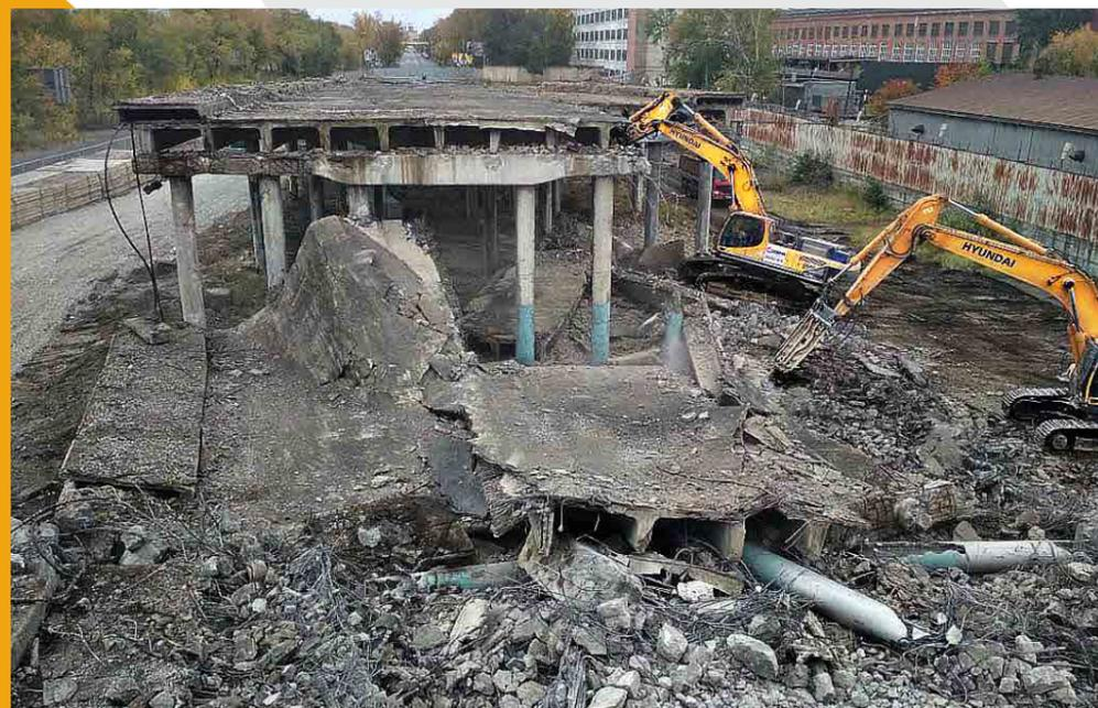
Комплексная работа экскаваторов с гидромолотом и гидроразрывными инструментами при демонтаже путепровода на проспекте Машиностроителей, г. Курган, 2019 г., ГСК «РЕФОРМА»
