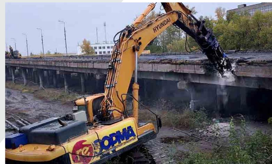
Последовательное обрушение конструкций экскаватором с гидроразрывниками, г. Курган, 2019 г., ГСК «РЕФОРМА»
