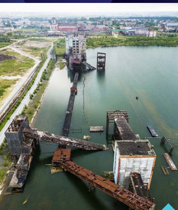
уцелевшие конструкции фабрики
