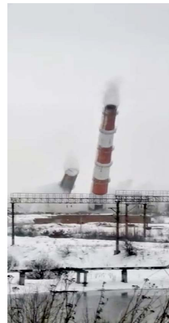
Взрыв дымовых труб
