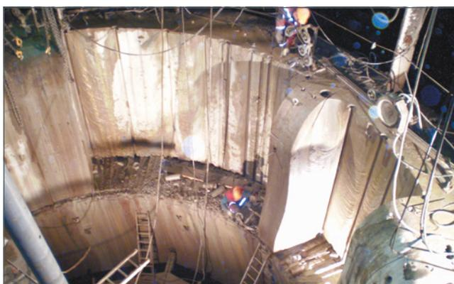
При демонтаже фундамента гидроагрегата (высота вырезанного железобетонного блока — 4 000 миллиметров, толщина — 1 000 миллиметров) применяется технология резки бетона канатными системами
