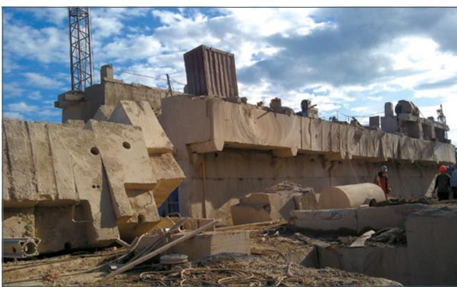
Технология алмазной резки используется для разборки очень мощных конструкций (в том числе монолитных толщиной от 1 000 до 2 500 миллиметров)
