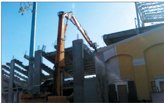
Экскаватор Demolition легко «перекусывает» несущие железобетонные конструкции толщиной до семисот миллиметров. Применение данной техники позволяет многократно увеличить скорость работ
