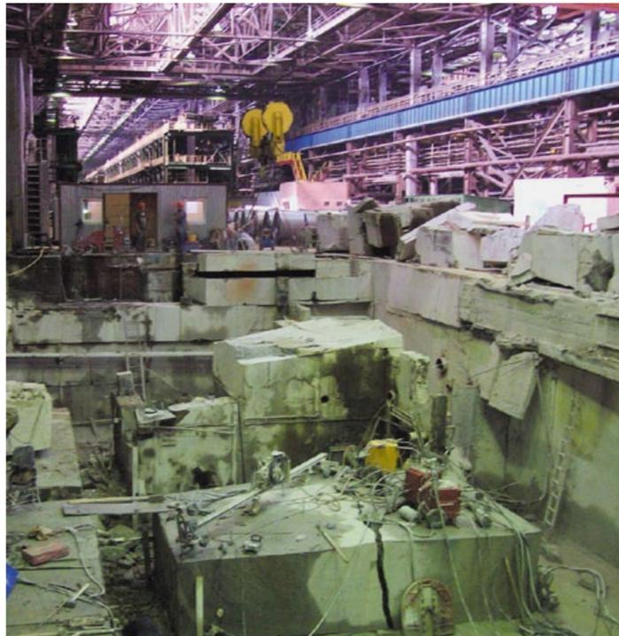
ственного сооружения очень часто требуются при замене оборудования, установке новой технологической линии. Снос производственных зданий на территории действующего предприятия необходим для освобождения площадки при новом строительстве.
