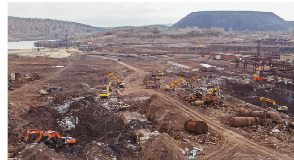
Завершающий этап демонтажа на промплощадке «Уфалейникель», работа спецтехники ГСК «Реформа», 2020 год
