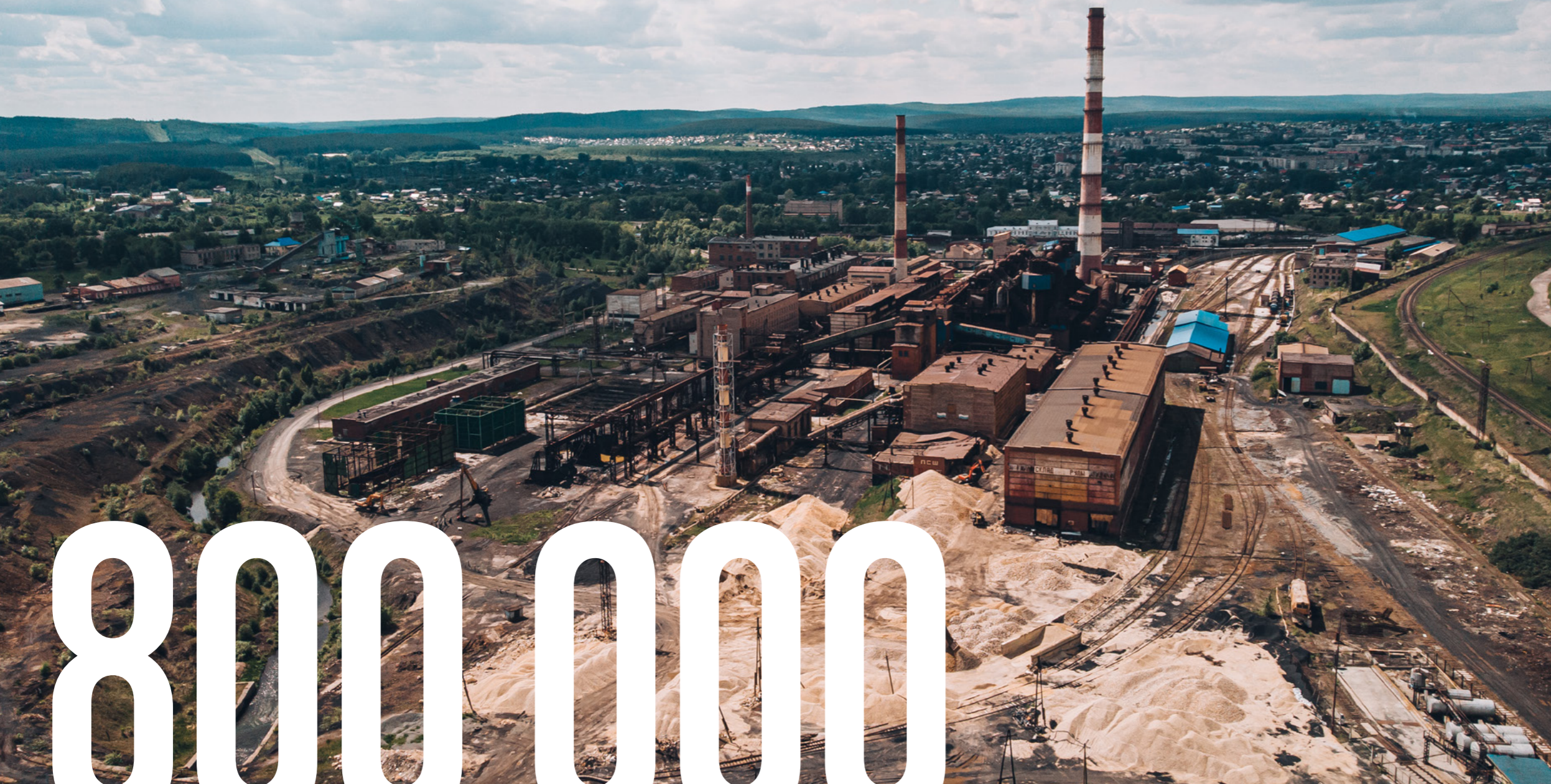
Комплекс «Уфалейникеля» до начала демонтажных работ, г. Верхний Уфалей, Челябинская область, 2020 год
