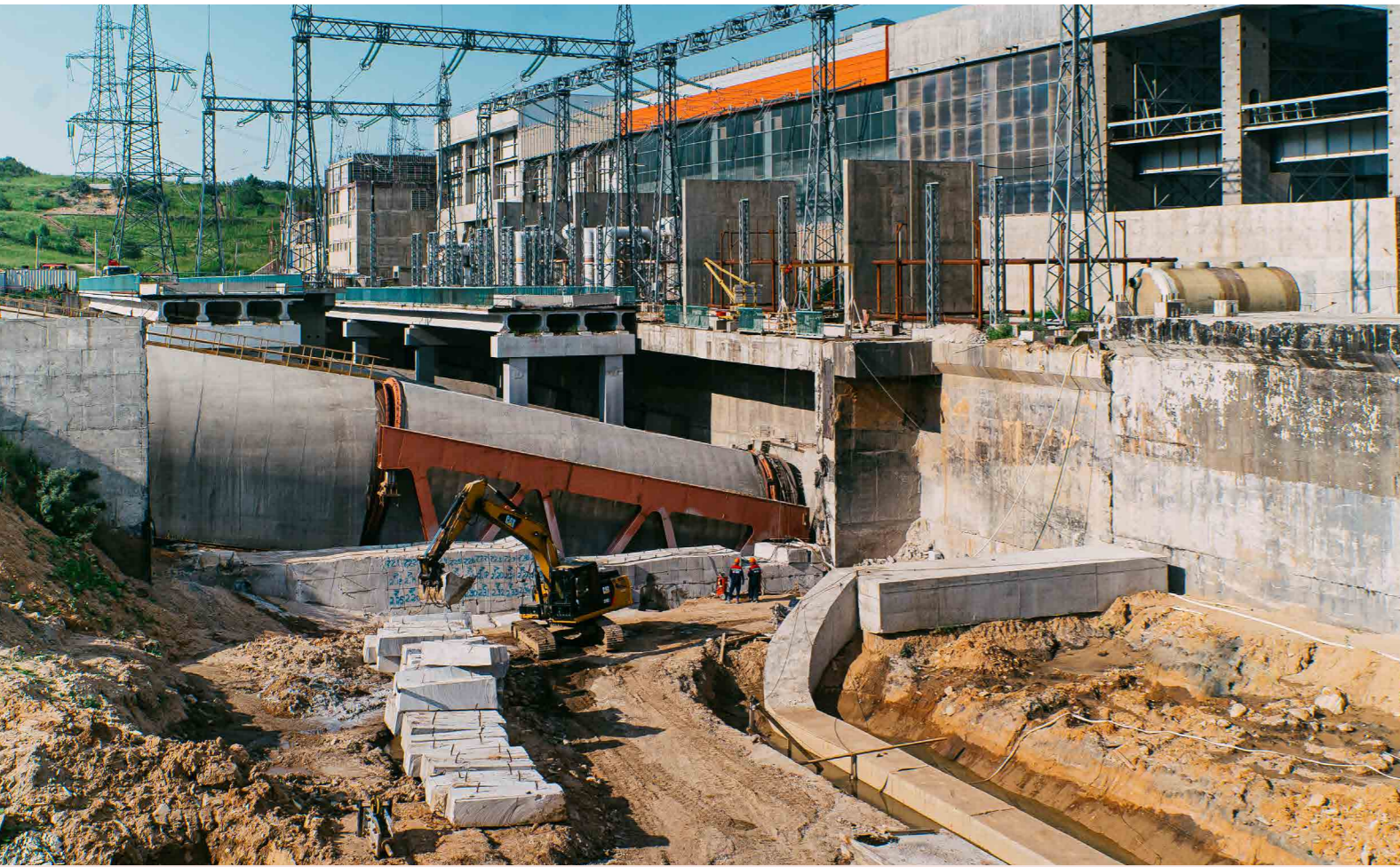
Демонтаж подпорных стен на Загорской ГАЭС-2: алмазная резка, установка анкерных рым-болтов, погрузка демонтированных бетонных блоков, Московская область, 2020 г., ГСК «Реформа»
