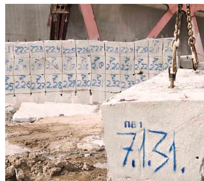
Средний размер блоков 0,5 X 0,5 X 2,5 м, вес около 2,5 т
