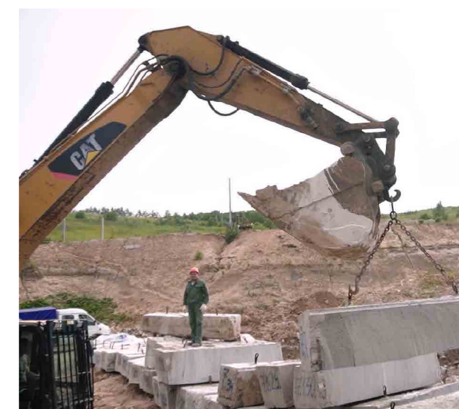
Погрузка бетонных блоков на Загорской ГАЭС-2
