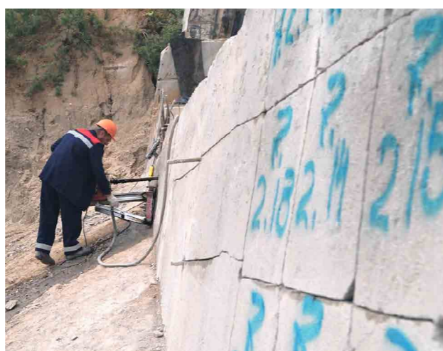
Разметка блоков для последующего демонтажа
