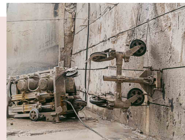
Алмазная резка в горизонтальной и вертикальной плоскостях на габаритные блоки
