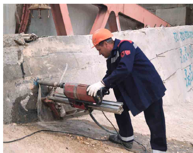
Бурение скважин установкой алмазного бурения Hilti DD350-CA BL 230V
